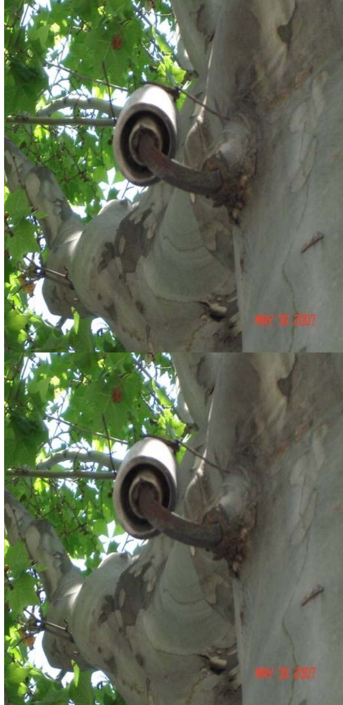
Şekil 12 ve 13. Ağaçlara elektrik fincanları (elektrik mesnetleri) takılmasına örnek
